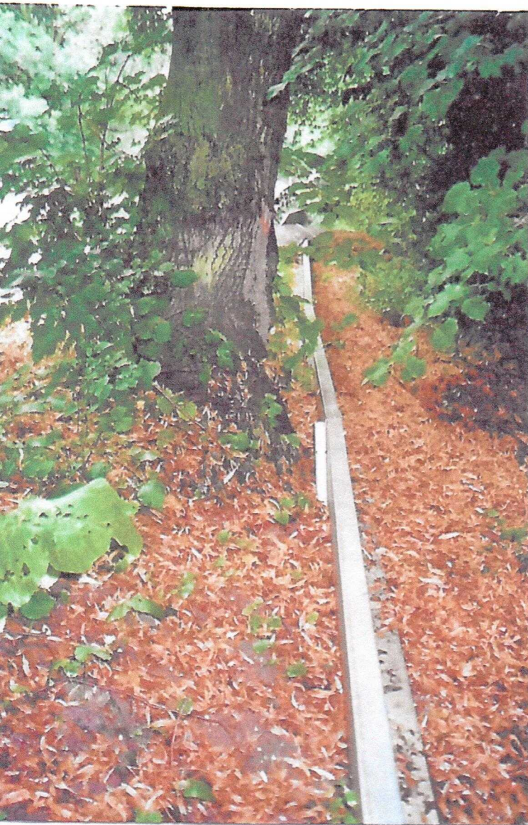
Südliche Leiteinrichtung mit Wurzelentfernung an Bäumen
